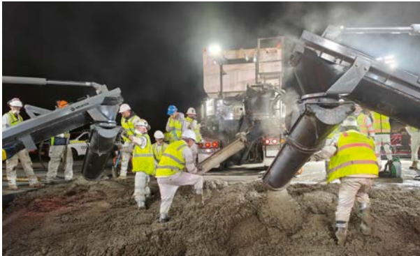
Australien: Flughafen MEL – Einbau Schnellbeton mit volumetrischen Betonmobilen bei einer Plattenstärke von 60 cm ohne Bewehrung. (Bild: Ebicon)
