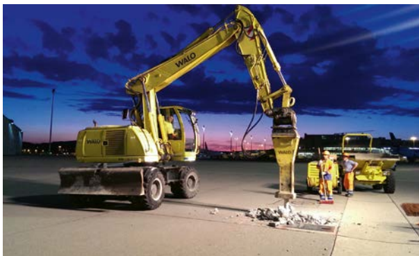
Schweiz: Flughafen ZRH – Ausbruch mit Spitzhammer. (Bild: Ebicon)
