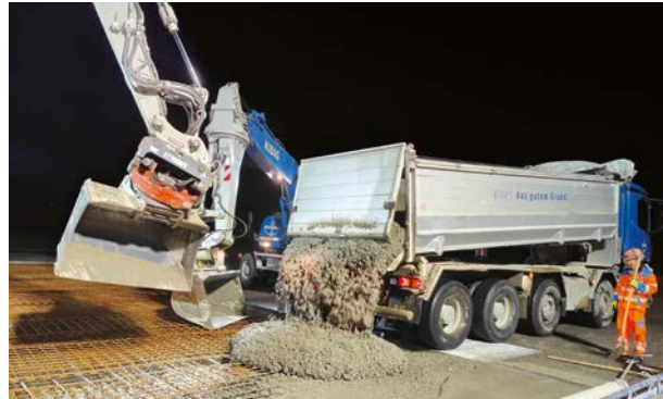
Schweiz: Flughafen ZRH – Einbau Schnellbeton mit Transportbeton bei einer Plattenstärke von 35 cm und Bewehrung. (Bild: Ebicon)
