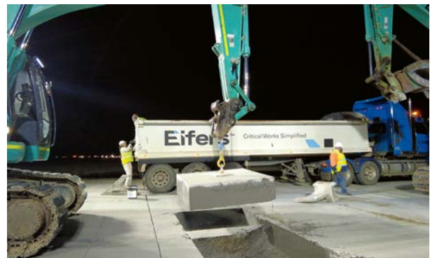
Australien: Flughafen MEL – Aushub der vorgeschrittenen Platten. (Bild: Ebicon)
