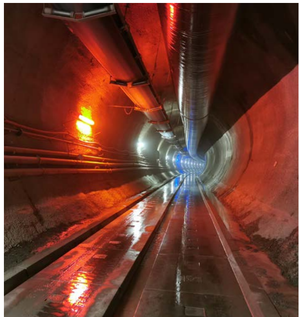
Bei der Sanierung des Tunnels Taubenloch bei Biel galt es, die Arbeiten in der Nacht durchzuführen, damit der Verkehr tagsüber fließen konnte. (Bild: Ebicon)
