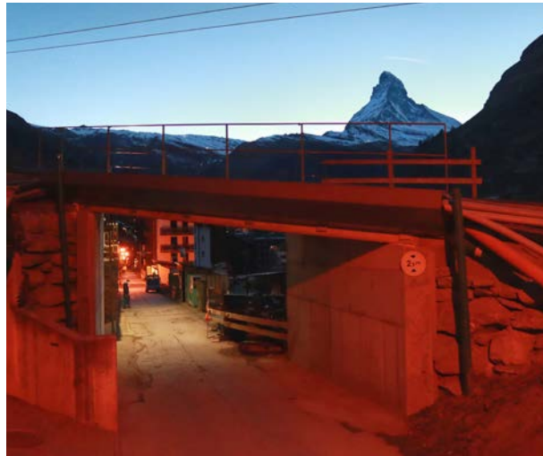
Eine denkwürdige Baustelle: die Sanierung der Gornegratbahn im autofreien Zermatt. (Bild: Ebicon)
