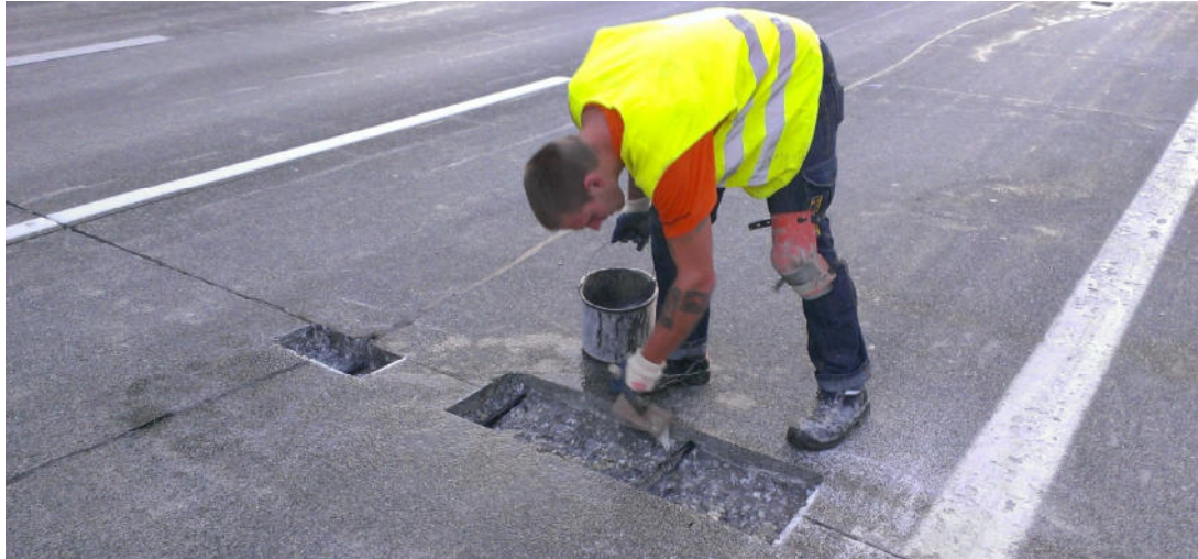
Illustration: Pré humidification du sous-sol
