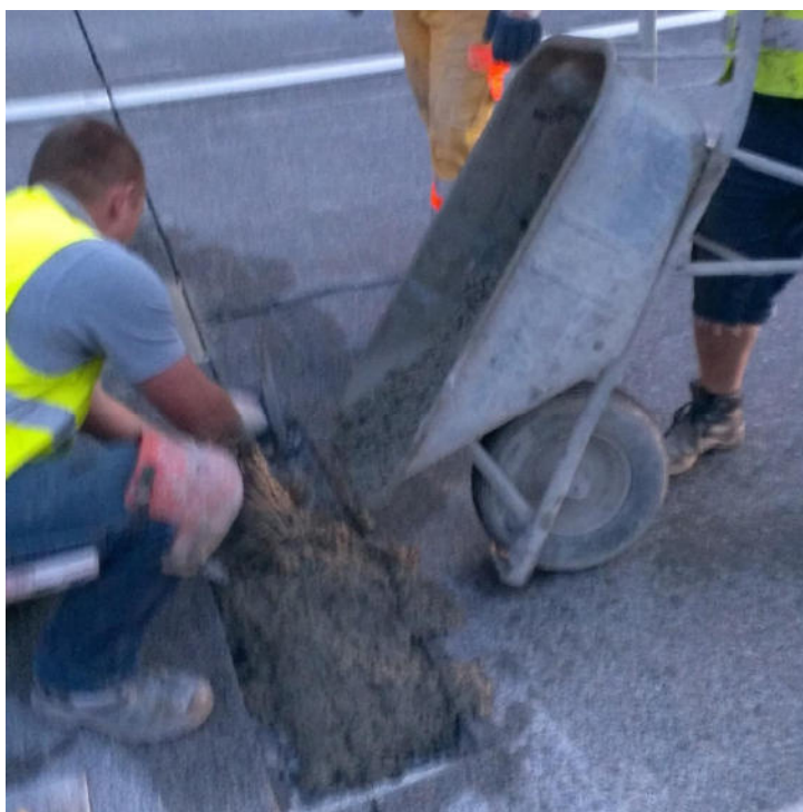
Illustration: Pose du mortier de réparation
