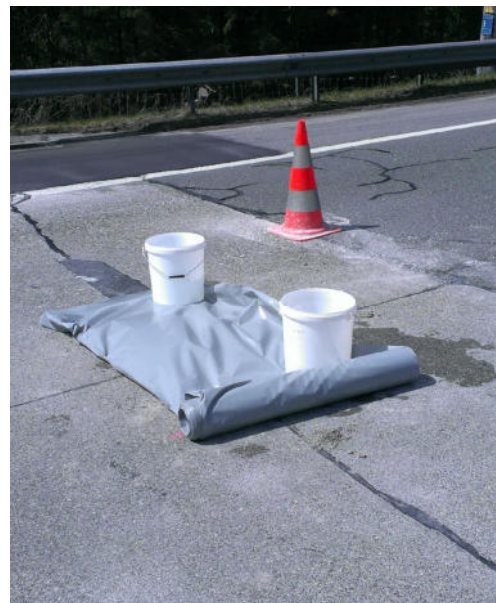
Illustration: Gauche : Application du post-traitement / Droite : Protection contre l'évaporation
