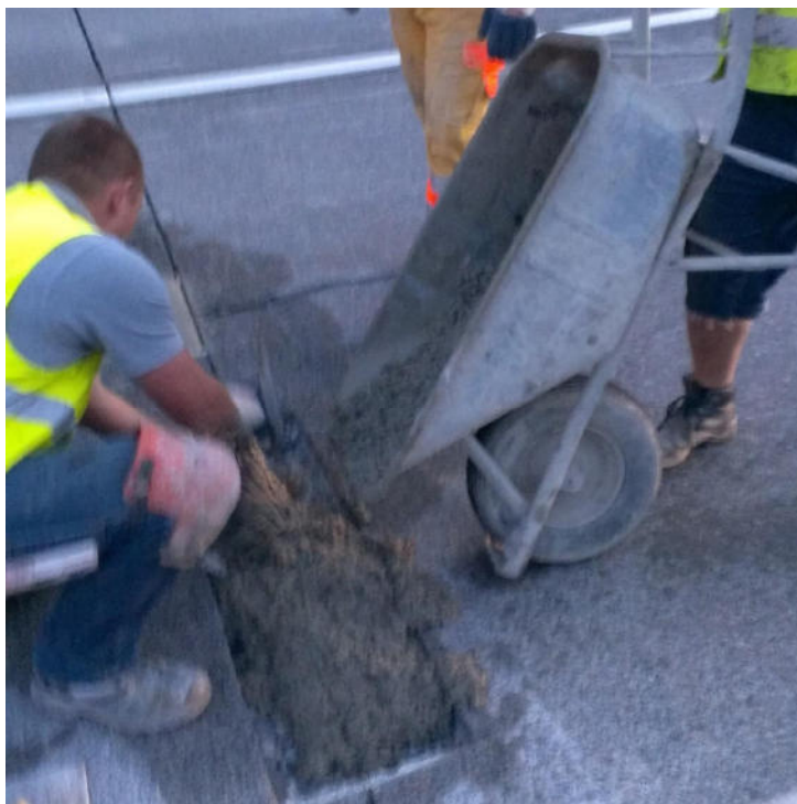
Illustrazione: posa della malta di riparazione
