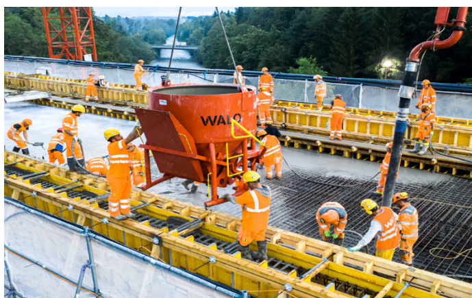
Bétonnage du pont ferroviaire - "Senseviadukt"
