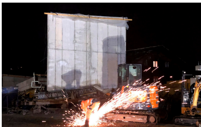
Rénovation du pont ferroviaire "Gomergratbahn"
