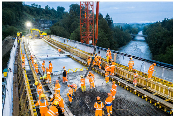
Gettata in opera del trogolo del ponte e del bordo 570 m 3
