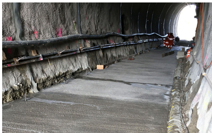
Rinnovo della base del tunnel ferroviario - "Russentunnel"
