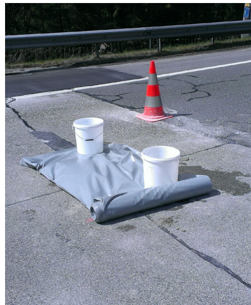
Illustrazione: A sinistra: applicazione del post-trattamento / A destra: protezione dall'evaporazione
