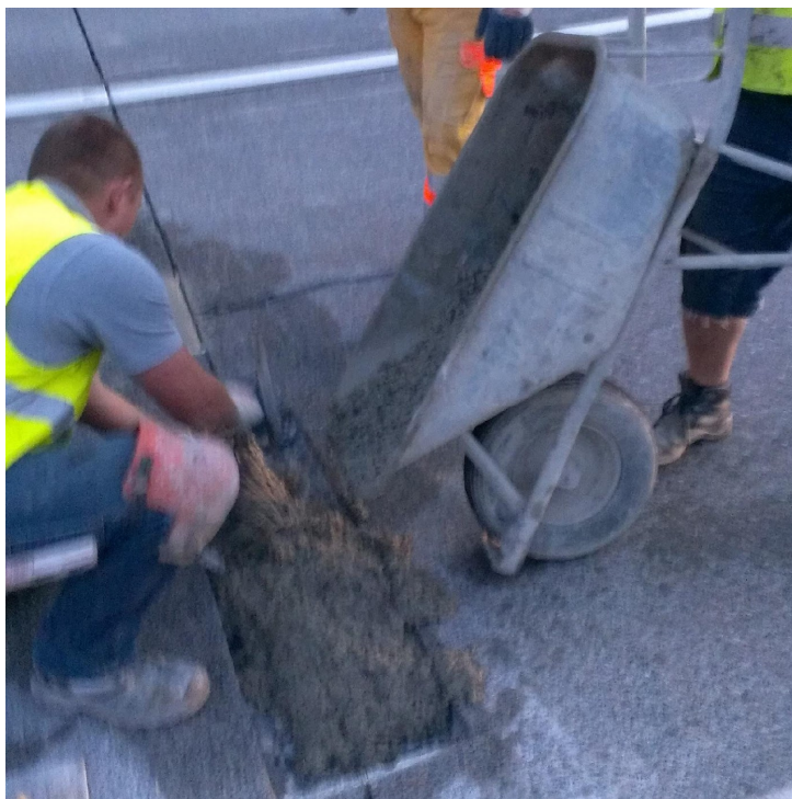
Illustrazione: posa della malta di riparazione
