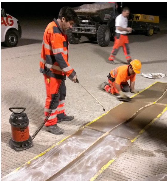
Illustrazione: A sinistra: applicazione del post-trattamento / A destra: protezione dall'evaporazione
