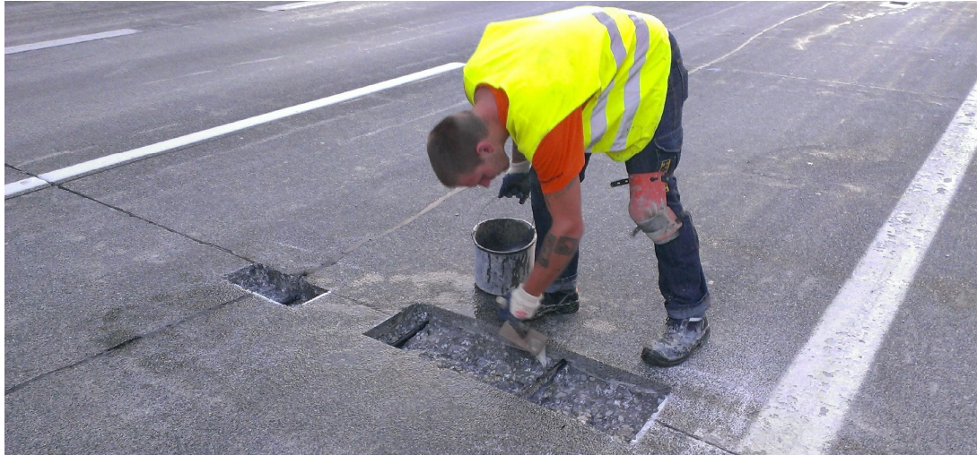
Illustrazione: Pre-umidificazione del sottofondo
