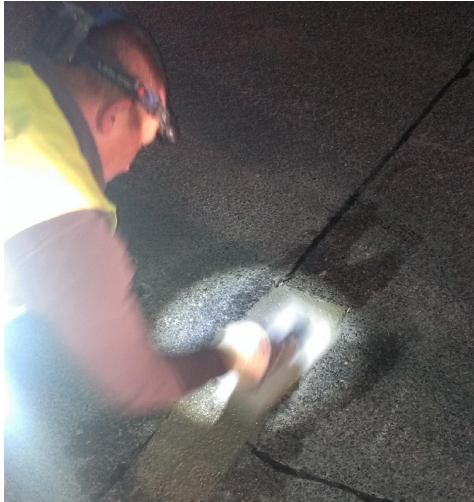
Illustrazioni: sinistra: lisciatura / destra: striatura
