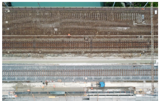
Luftaufnahme der sechs Gleise und des neuen Fusswegs
