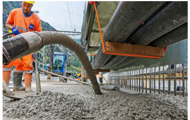
Einbau Pumpbeton
