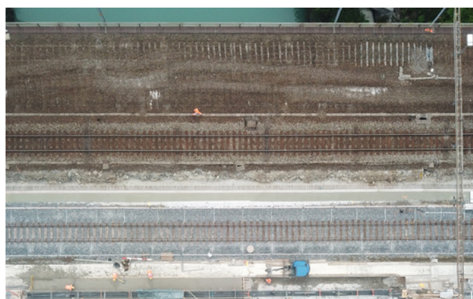
Vue aérienne des six voies et du nouveau trottoir
