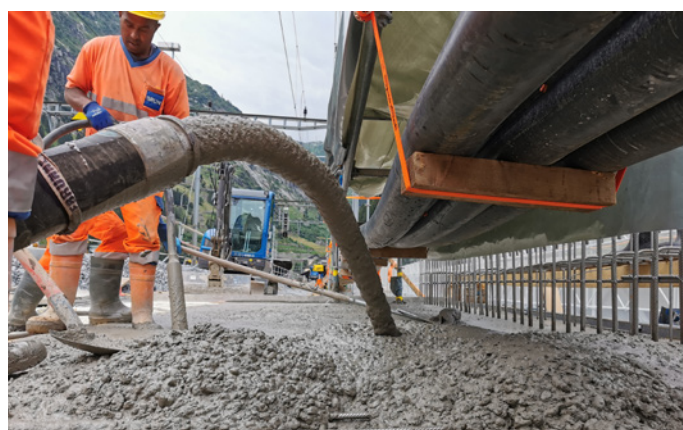
Mise en œuvre du béton pompé
