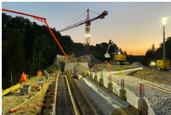
Les pieux (25 m 3 ) sont déjà utilisés, tandis que le mur de soutènement est en train d'être préparé pour le bétonnage.
