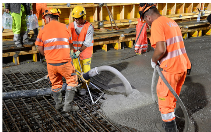
Béton pompé pour le tablier du pont
