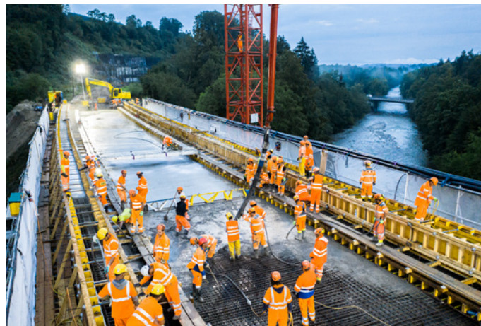
Bétonnage du tablier du pont et la bordure, 570 m 3
